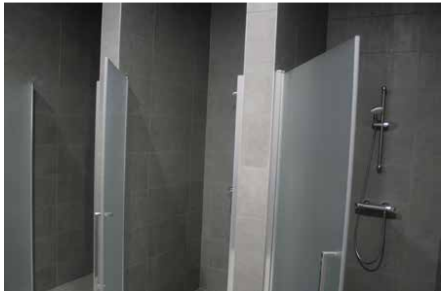
De compacte boiler voor hoekopstelling werd geïnstalleerd voor het douchecomfort van de medewerkers.
