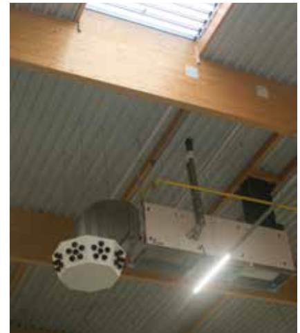
Het Smitsair inducerend jetsysteem optimaliseert de luchtverdeling in de industriële loods.
