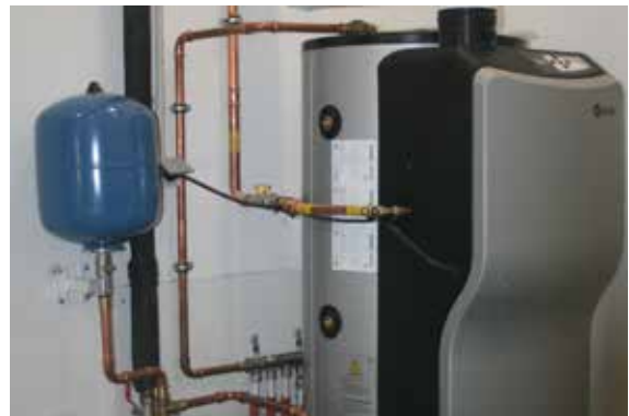
De volledig gesloten condenserende hoogrendements gasboiler Innovo van A.O. Smith heeft een kleiner vermogen – minder dan 30 kW
